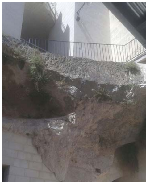
Area di ubicazione del percorso ascensore vico Commercio – vico Lombardi. Parete di calcareniti.
