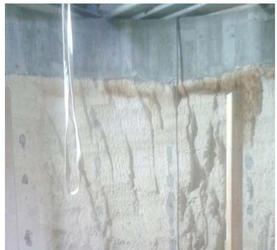
Rione Casalnuovo. Percorso ascensore. Parete di scavo nelle calcareniti.
