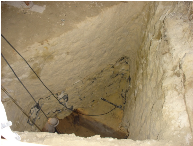
Piazza Vittorio Veneto. Percorso ascensore. Pareti di scavo nelle calcareniti a quota tra - 4.00 m e - 6.00 m.
